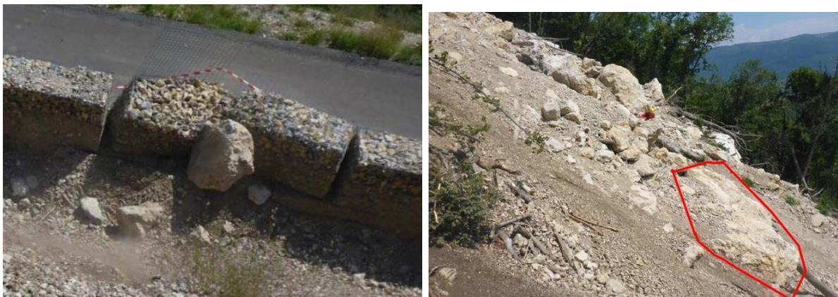
illustration 50 – exemple avec un bloc remobilisé de 600 l environ le 14 août 2018, ou avec une masse de 50 m<sup>3</sup> suspecte, potentiellement remobilisable en cas d'affouillement marquée (photos IMS RN)
