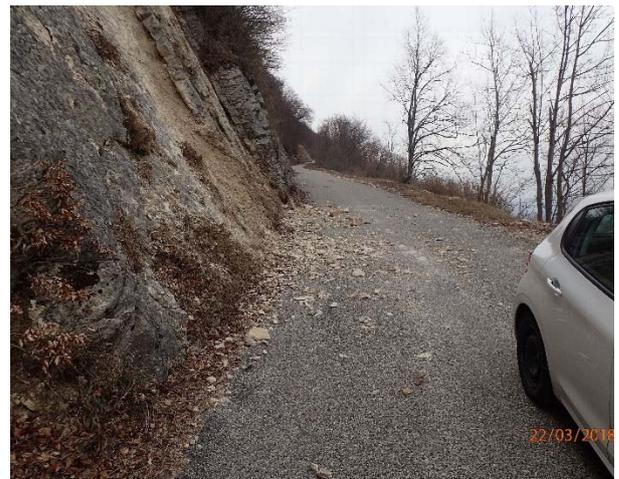
*illustration 54 : chute de pierres et petits blocs par le gel hivernal épanchés sur la RD120 (hiver 2017-2018)*
