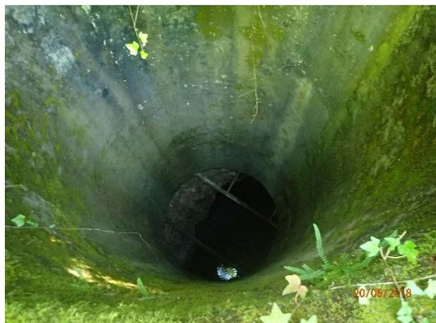
*illustration 37 – puits au cuvelage béton retrouvé en aval de la fosse inférieure*
