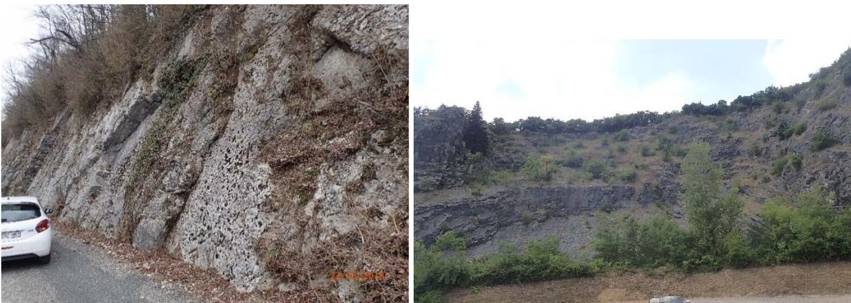
illustration 46 – configuration rupture et glissement plan des couches en aval pendage redressé (RD120 du flanc est et ancienne carrière de l'avenue de la Gare)
