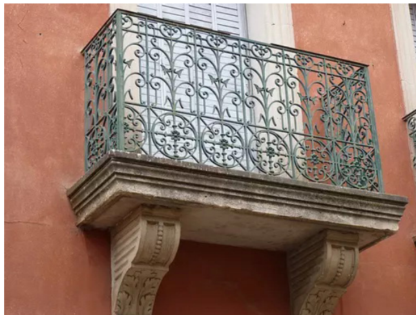
Les ferronneries : des éléments importants à valoriser
