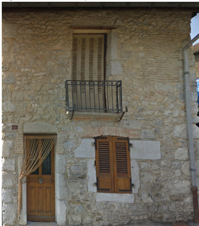
Façades du centre historique de Culoz
