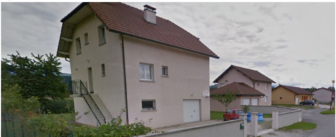
Façades de maisons individuelles dans la plaine
