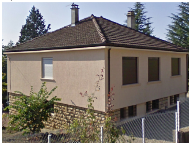
Façades de maisons individuelles sur le coteau
