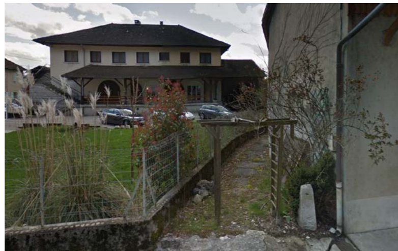
photographies du Ponan un ruisseau busé entièrement vue depuis la rue de l'Amiral Serpollet
