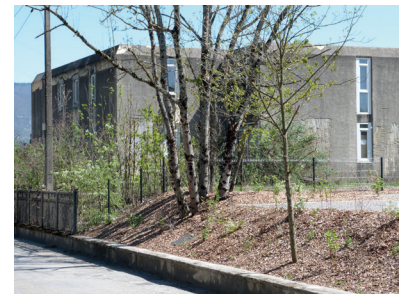
Projet de réalisation de 18 logements collectifs dans un ancien immeuble de bureaux
