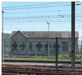
Bâtiment ferroviaire emblématique
