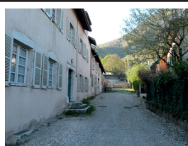
Appartements dans bâtiment rénové
