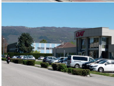
Bâtiments volumineux le long de la RD904
