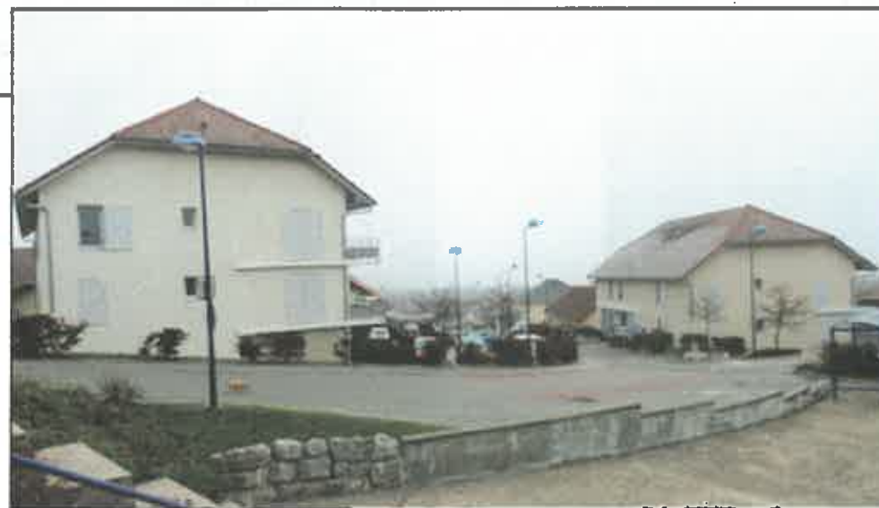
Logements collectifs à Clusy
